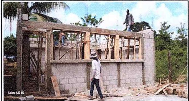
Foto 2: Reparación y cambio del techo de la cocina del edificio escolar
